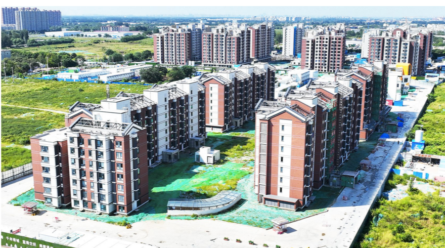
施工现场,以棕红、米白色为主色调的建筑外立面已经亮相。记者 常鸣/摄
