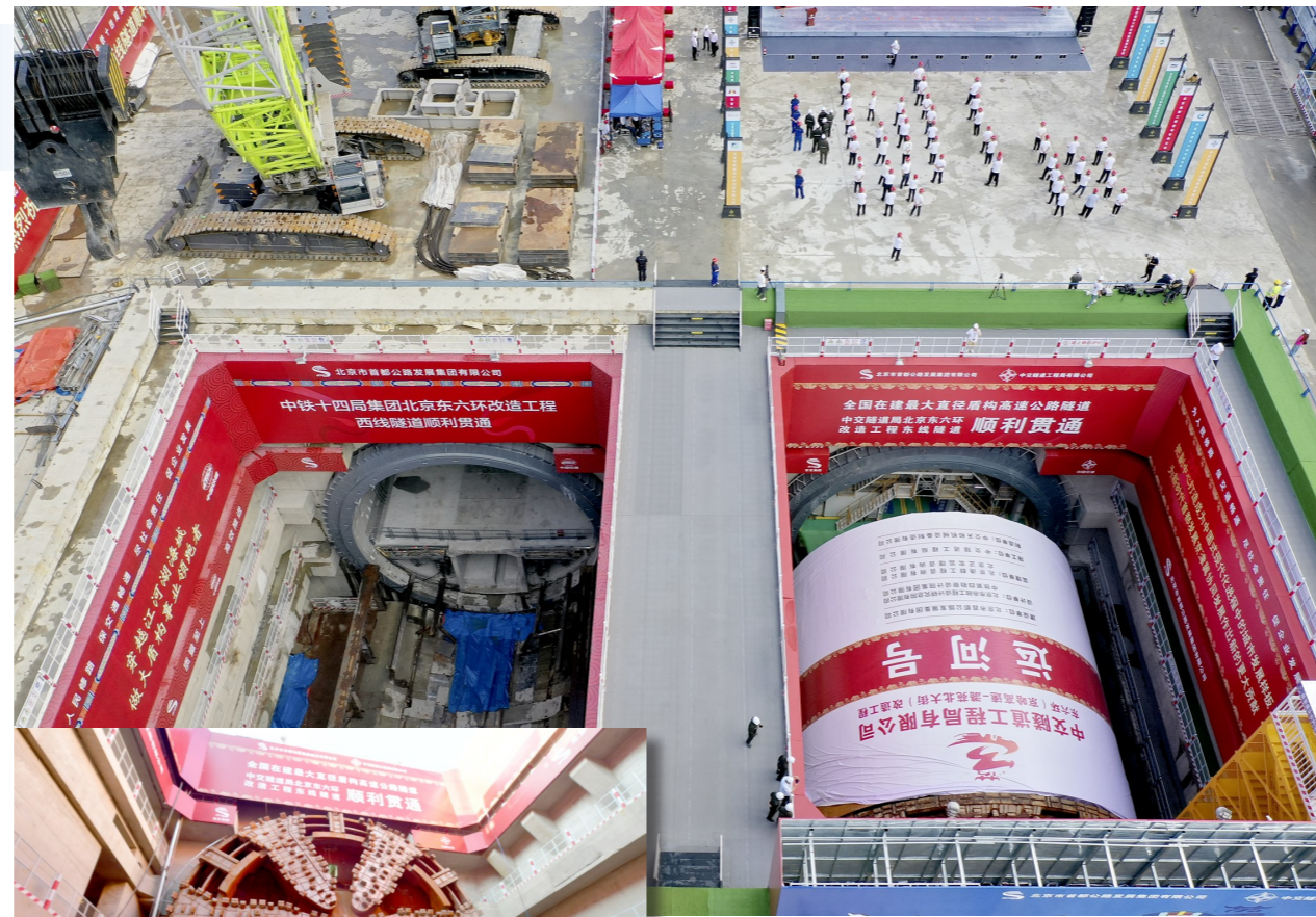
东六环改造工程东线和西线隧道已全部贯通。
