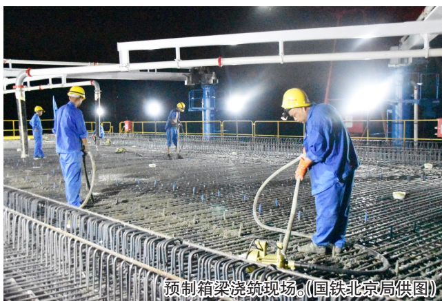
(预制箱梁浇筑现场。(国铁北京局供图))
