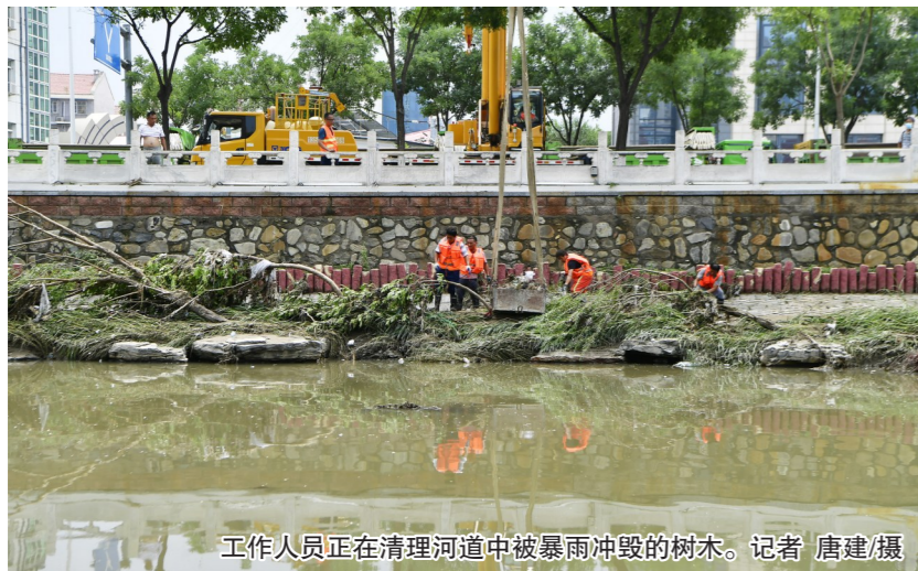
工作人员正在清理河道中被暴雨冲毁的树木。记者 唐建/摄
