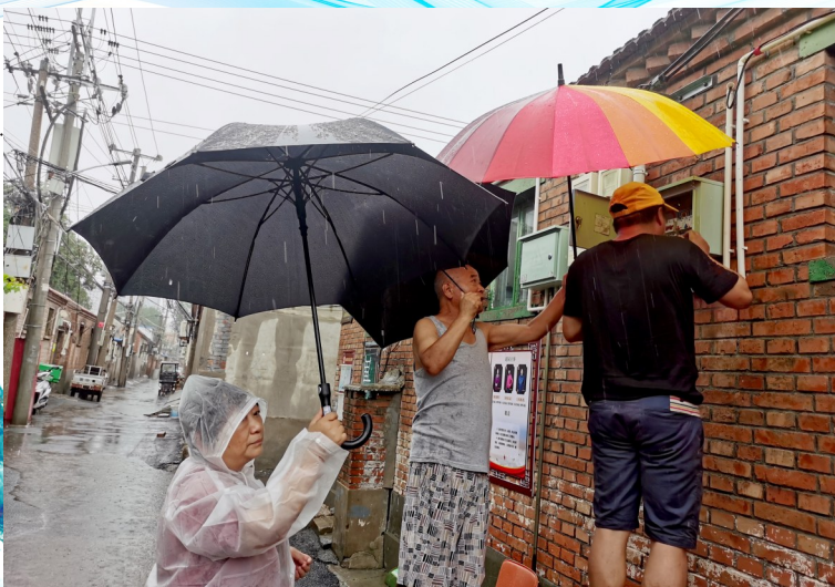
中仓街道白将军社区,电工冒雨为居民抢修电路。
