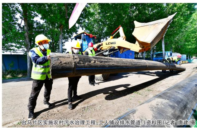
台马片区实施农村污水治理工程，工人铺设排水管道。(资料图)记者 唐建/摄
