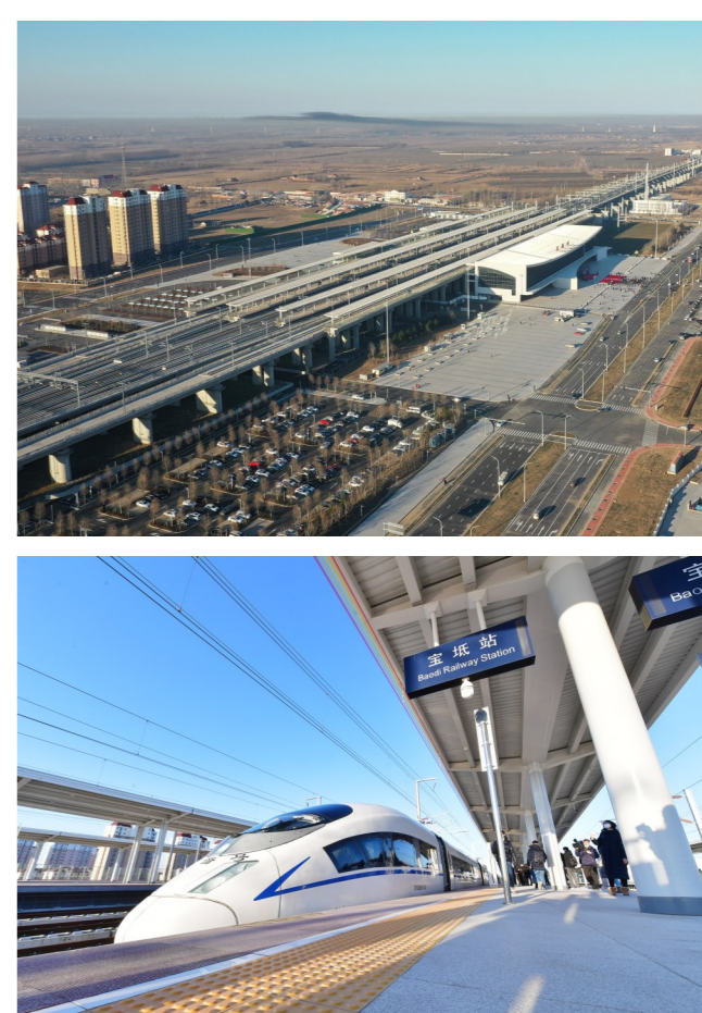
京唐城际铁路宝坻站
