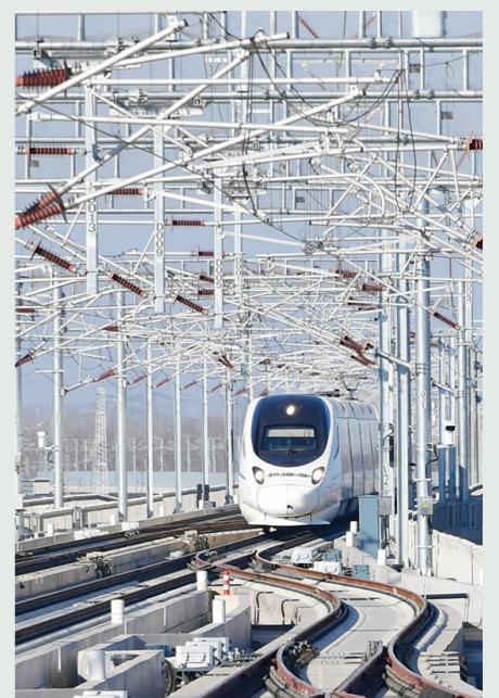
京唐城际铁路
