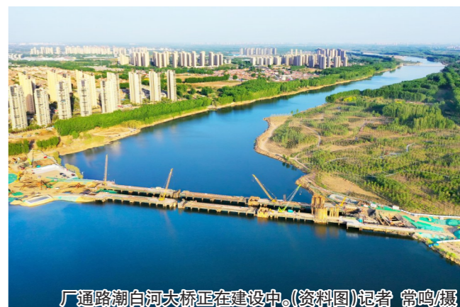
厂通路潮白河大桥正在建设中。（资料图）记者 常鸣摄
