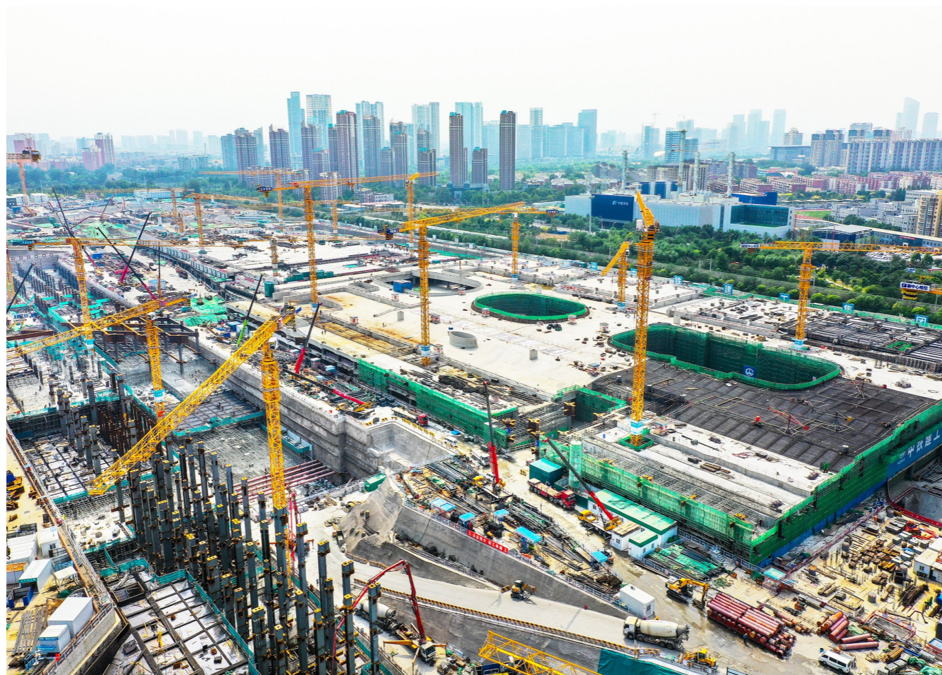
副中心站枢纽工程主站房西区实现主体结构封顶,“京帆”屋盖建设预计8月施工。记者 常鸣/摄
