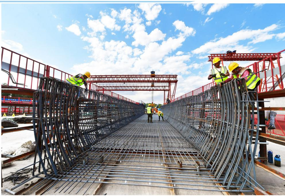
工人正在进行U型梁的钢筋网施工。记者 常鸣/摄
