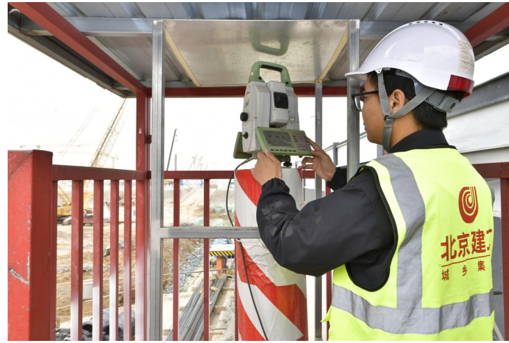
工人正在操作基坑实时监测机器人系统。 记者 唐建/摄
