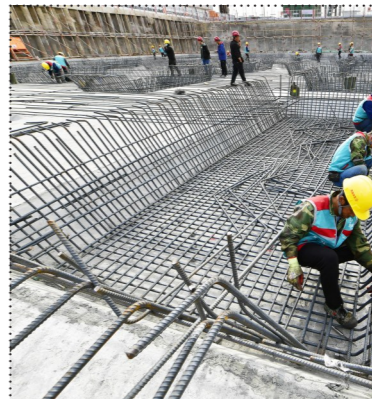
北泡轻钢地块二期项目正在进行地下阶段施工。记者 唐建/摄
