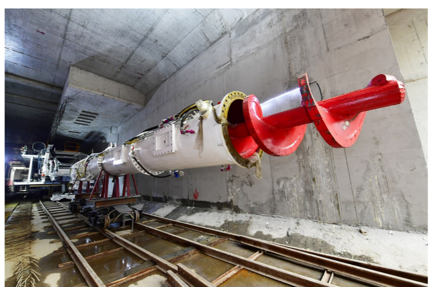
政务中心站正在施工,是22号线进展最快的地下车站。记者 唐建/摄
