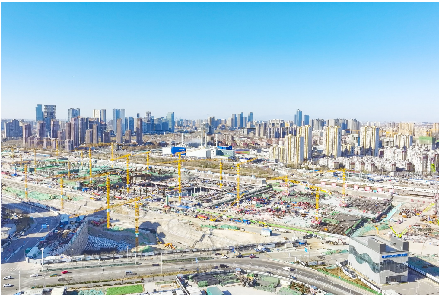
副中心站综合交通枢纽是“轨道上的京津冀”的重要支点。图为施工中的枢纽工程。(资料图)记者 常鸣/摄
