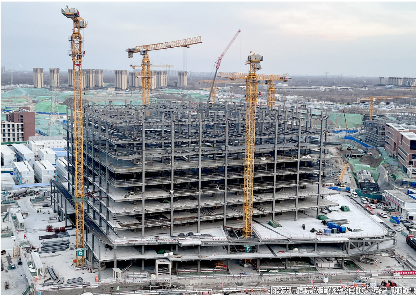
北投大厦已完成主体结构封顶。记者 唐建/摄
