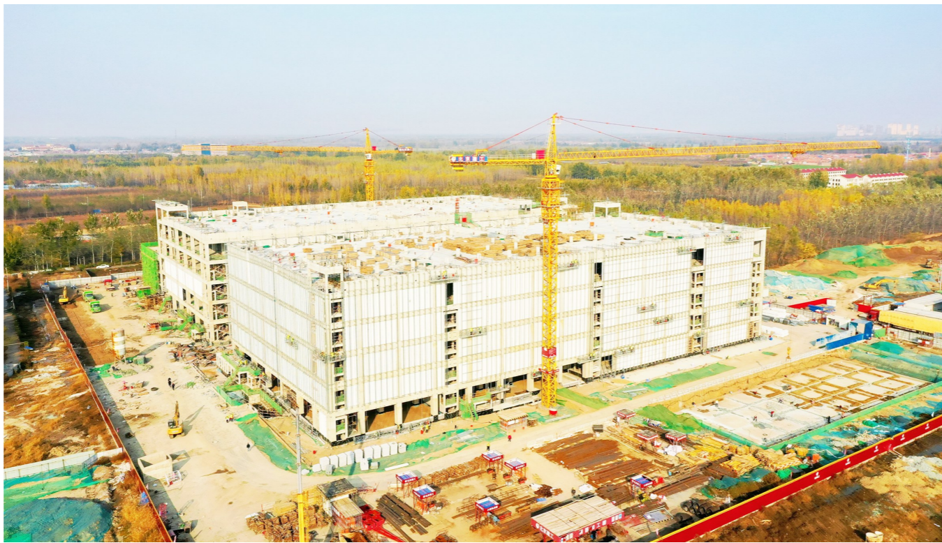
电投工业互联网数据安全信息港项目主体结构已正式封顶。记者 常鸣/摄
