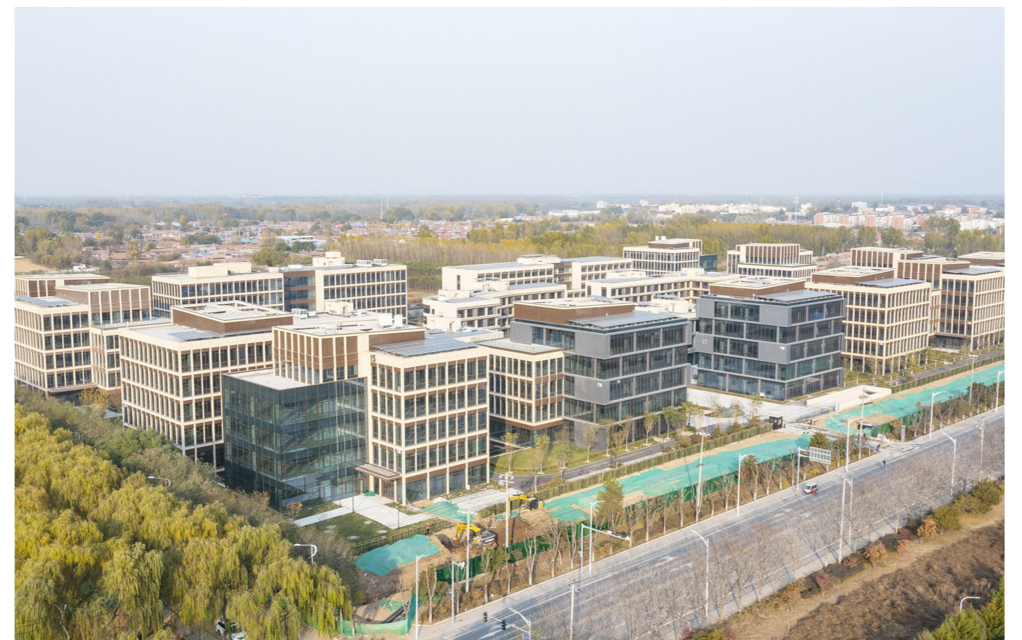
一方健康谷坐落于潮县医药健康产业集聚区,致力于打造城市副中心标志性的医疗健康智慧园区。记者 常鸣/摄
