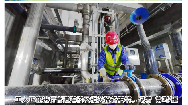
工人正在进行管道连接及相关设备安装。记者 常鸣摄
