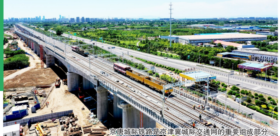
京唐城际铁路是京津冀交通网的重要组成部分。
