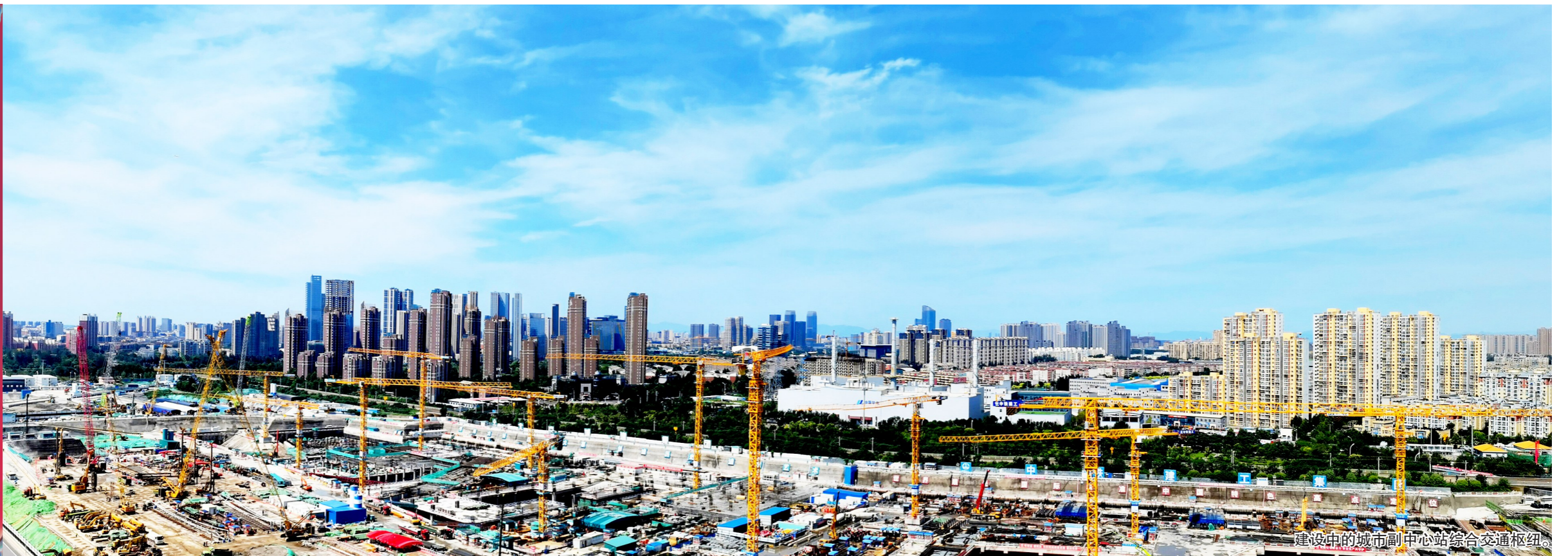
建设中的城市副中心综合交通枢纽。
