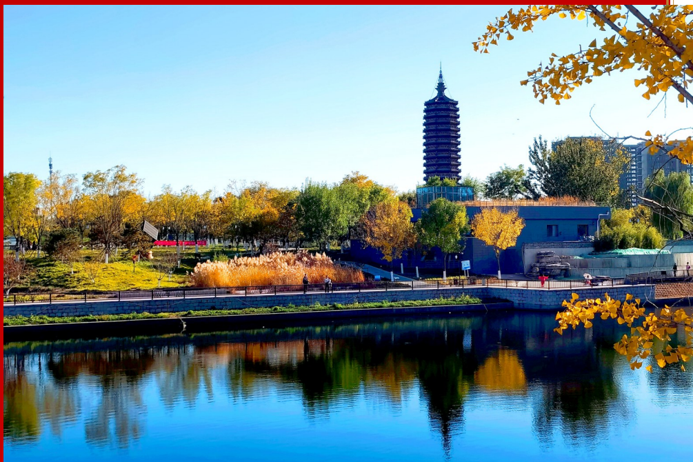
一枝塔影认通州,从古至今,燃灯塔始终都是通州的地标性建筑。
