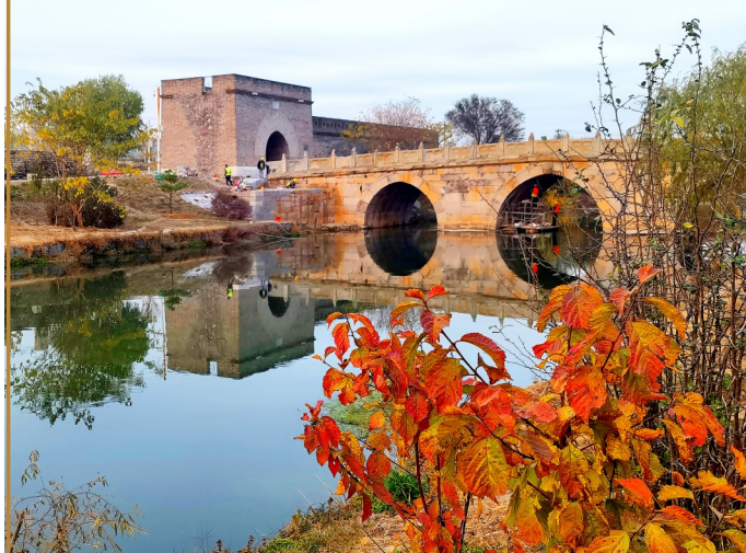
位于张家湾镇的通运桥沧桑、古朴。
