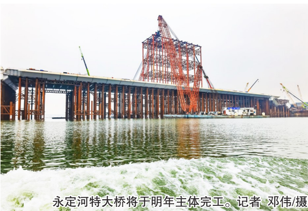
永定河特大桥将于明年主体完工。记者 邓伟/摄
