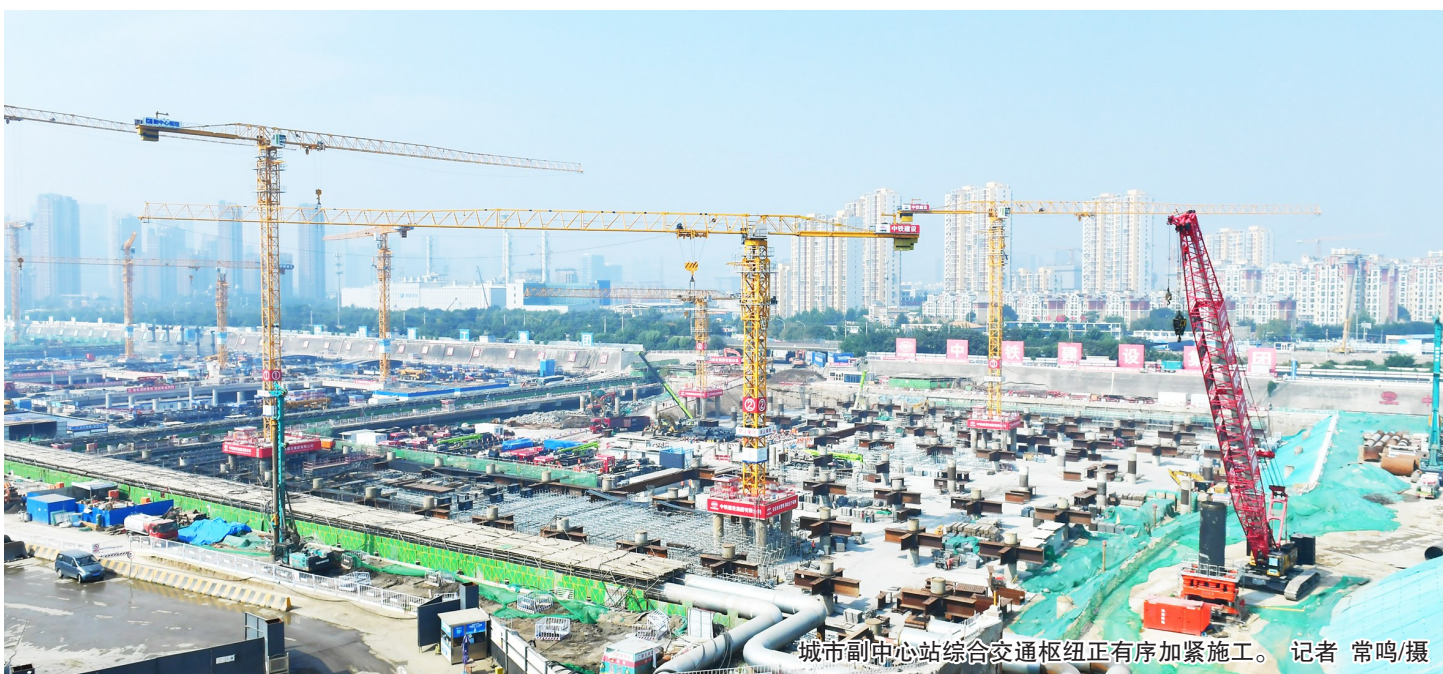
城市副中心站综合交通枢纽正有序加紧施工。 记者 常鸣/摄
