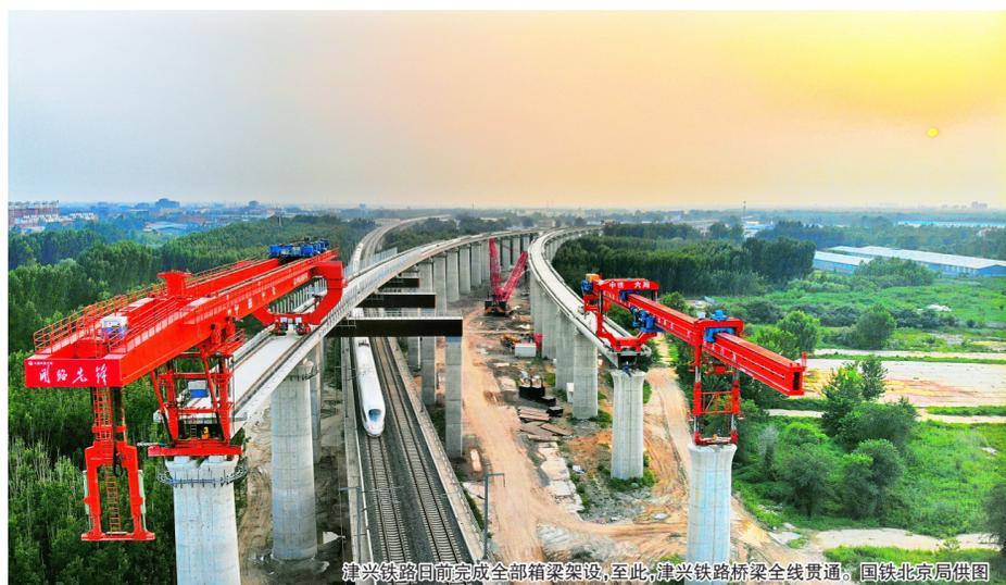
津兴铁路日前完成全部箱梁架设,至此,津兴铁路桥梁全线贯通。国铁北京局供图
