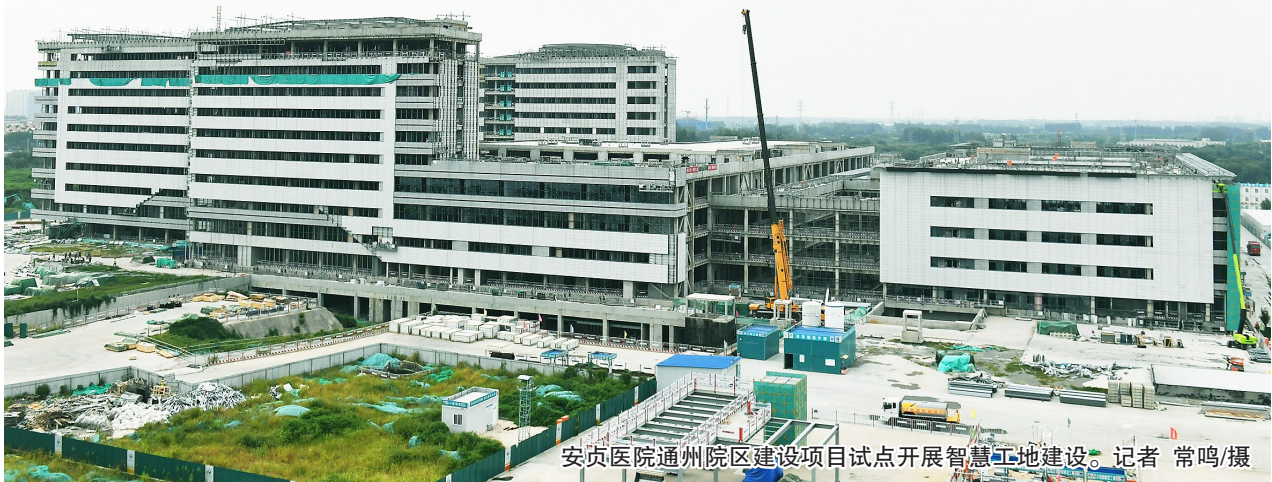
安贞医院通州院区建设项目试点开展智慧工地建设。记者 常鸣/摄
