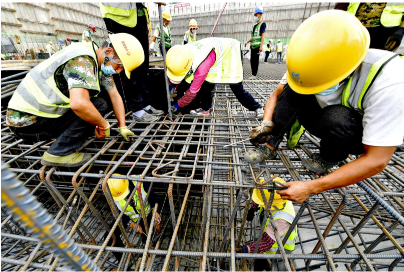
项目总占地2.8万平方米,预计2023年年底竣工。记者 唐建/摄
