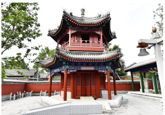
燃灯塔及周边古建筑群景区文物修缮工程已基本完工。
