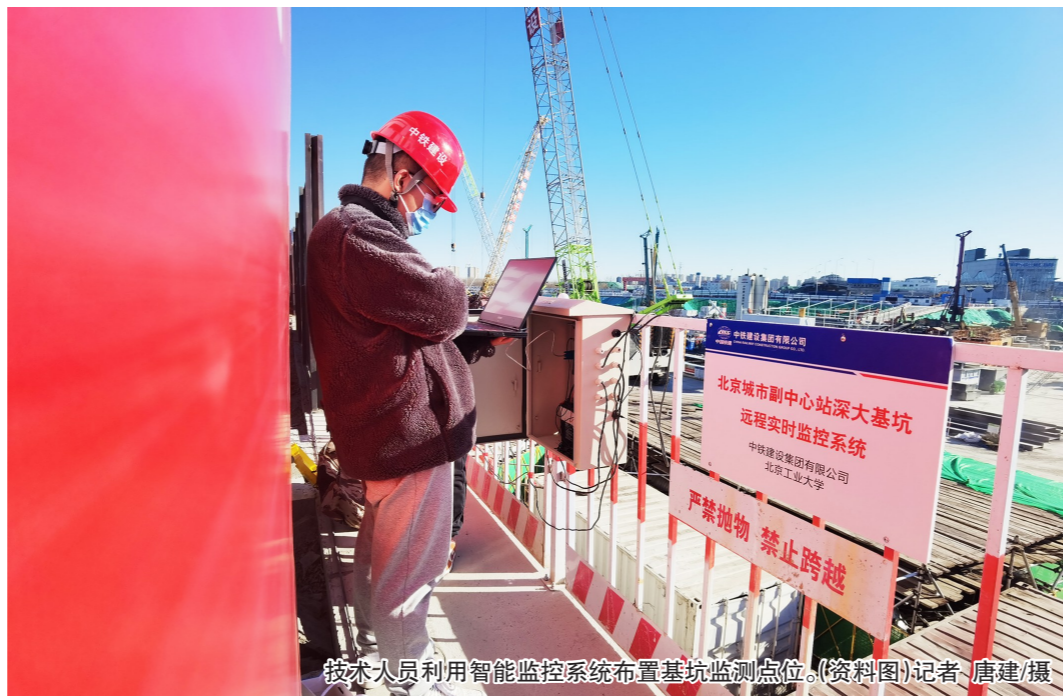
技术人员利用智能监控系统布置基坑监测点位。(资料图)记者 唐建/摄
