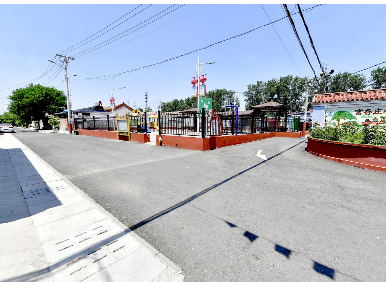
于家乡富各庄村已完成污水收集管网建设,道路上的雨篦子焕然一新。记者 唐建/摄
