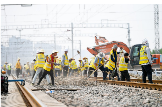
施工人员协同奋战,顺利完成唐山站津山线下行线拨接施工任务。 通讯员 丁玲/摄
