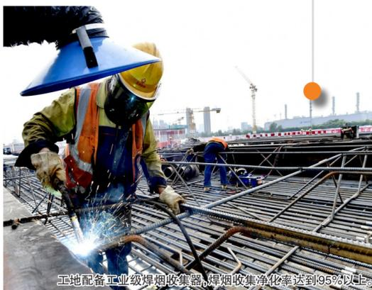
工地配备工业级焊烟收集器，焊烟收集净化率达到了95%以上。
