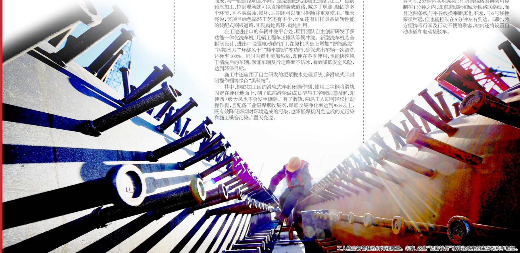
工人检查钢管柱与钢架焊接质量。未来，这些“钢筋铁骨”将撑起站房的主体结构和框架。
