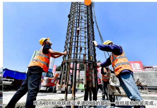
昨天，01标段中铁建设承建区域的最后一根抗拔桩吊装完成。
