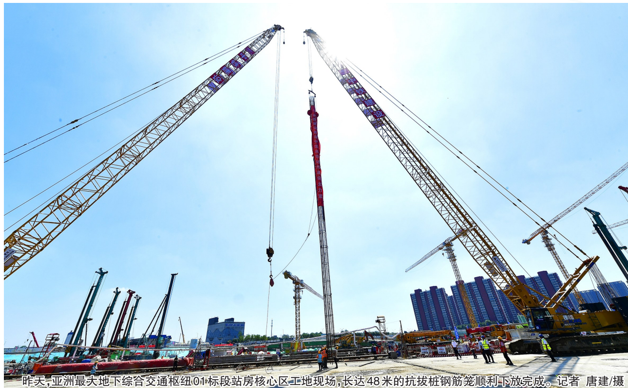
昨天,亚洲最大地下综合交通枢纽01标段站房核心区正地现场,长达48米的抗拔桩钢筋笼顺利下放完成。记者 唐建/摄
