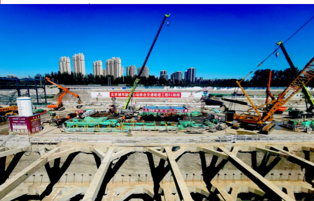
建设中的副中心站综合交通枢纽。
