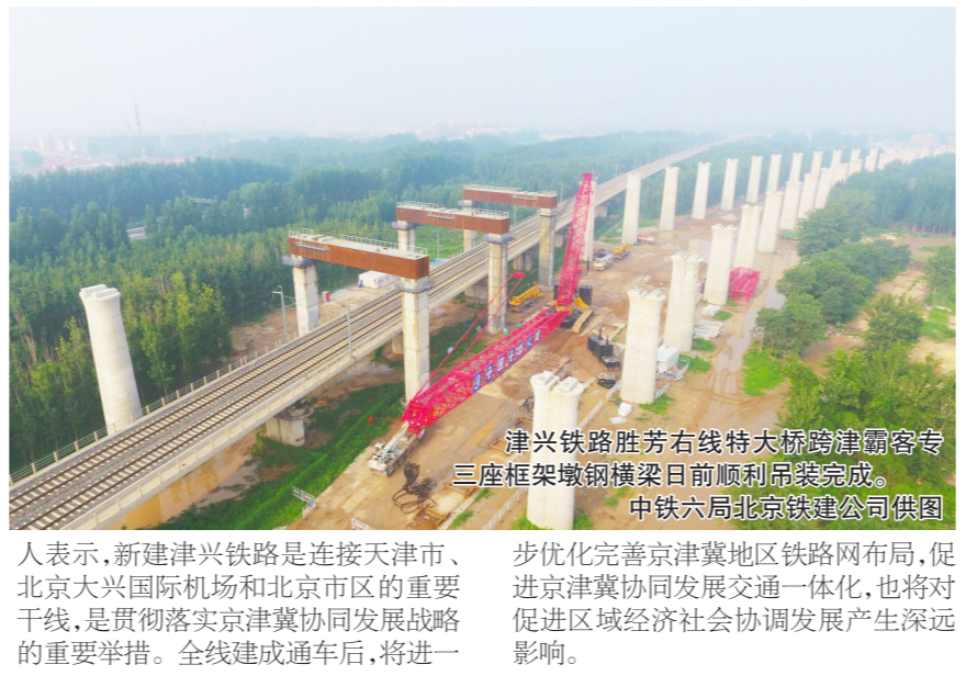
津兴铁路胜芳右线特大桥钢横梁日前顺利吊装完成。
