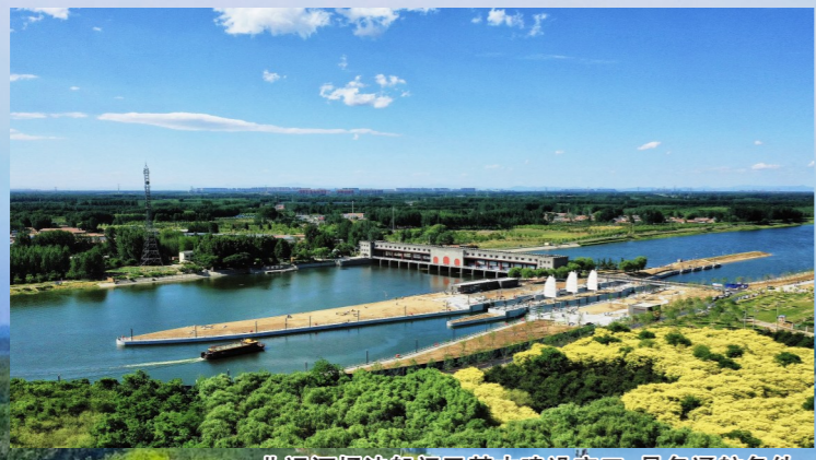
北运河杨洼船闸已基本建设完工,具备通航条件。
