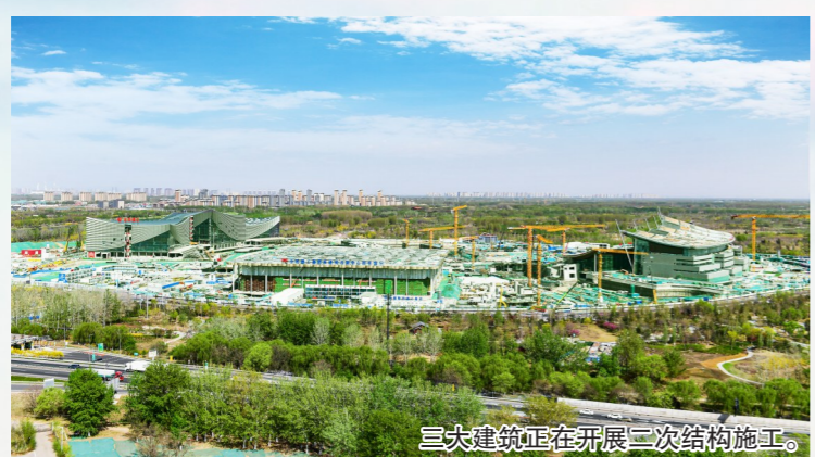
三大建筑正在开展二次结构施工。
