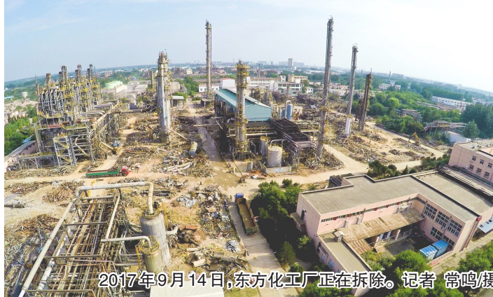
2017年9月14日,东方化工厂正在拆除。记者 常鸣摄
