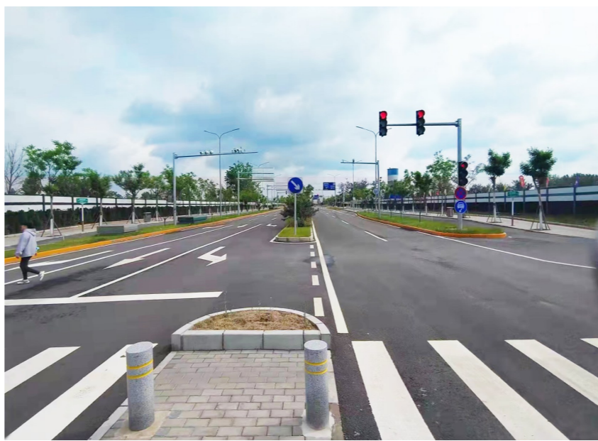
文化旅游区多条道路竣工验收,图为玉桥西路南延。记者 刘薇/摄
