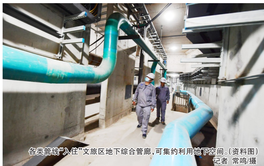
各类管线“入住”文旅区地下综合管廊,可集约利用地下空间。(资料图) 记者 常鸣/摄
