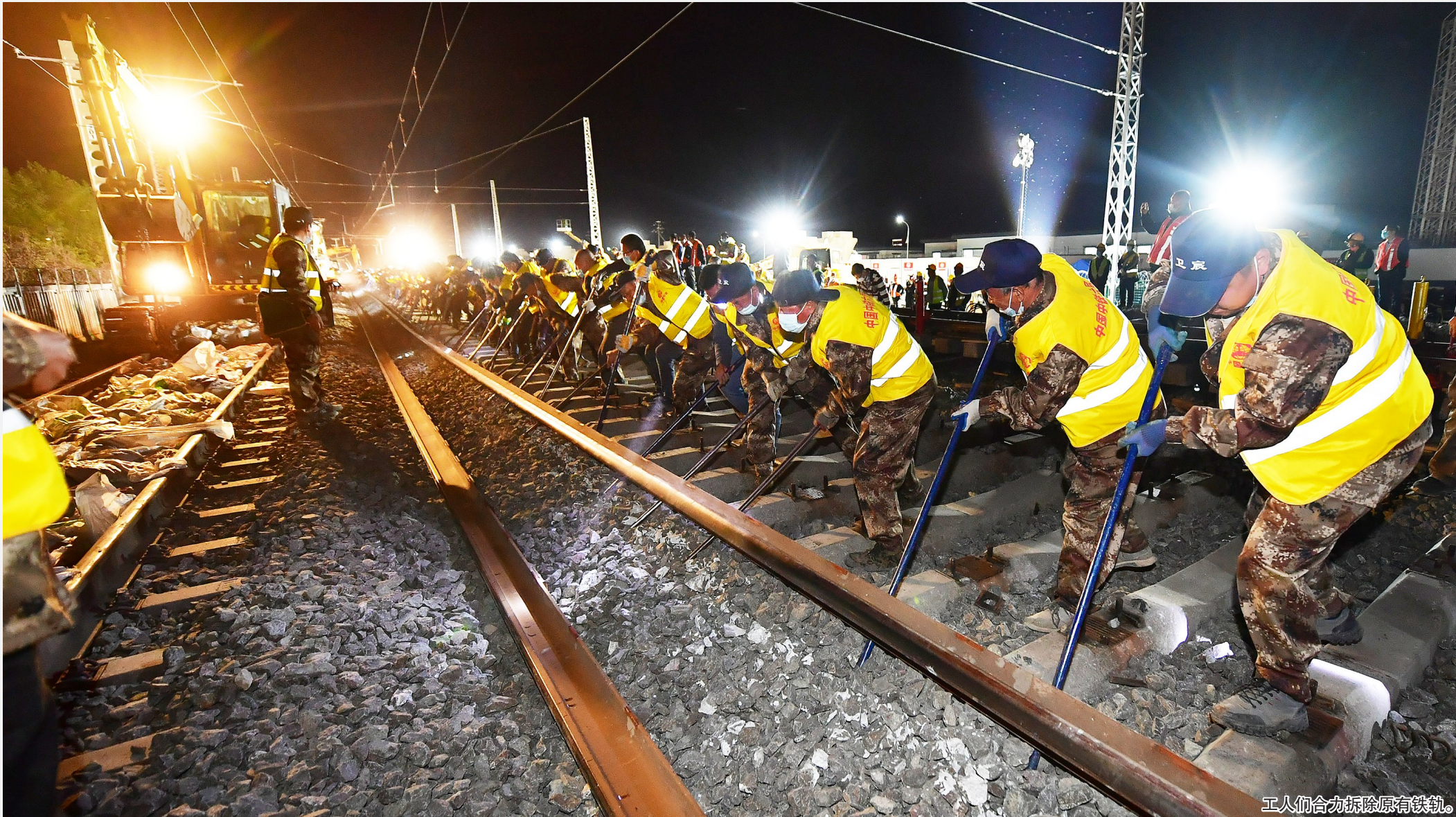
工人们合力拆除原有铁轨。
