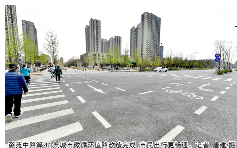
潞苑中路等41条城市微循环道路改造完成,市民出行更畅通。记者 唐建/摄
