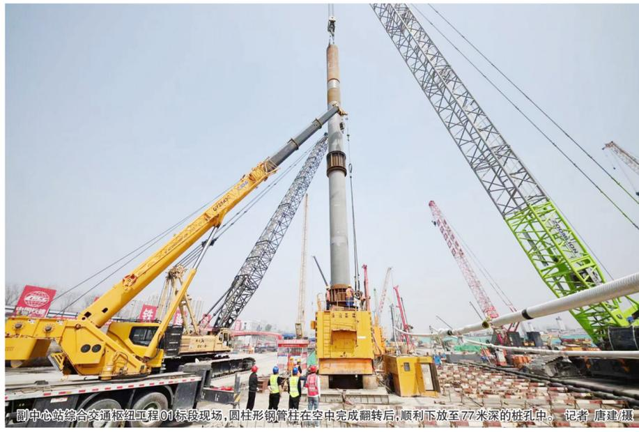
副中心站综合交通枢纽工程01标段现场,圆柱形钢管柱在空中完成翻转后,顺利下放至77米深的桩孔中。记者 唐建根
