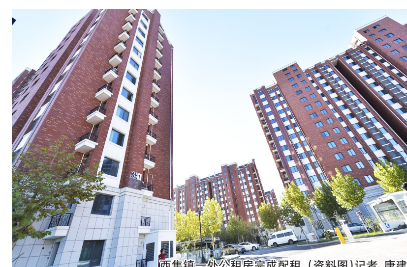
西集镇一处公租房完成配租。(资料图)记者 唐建/摄
