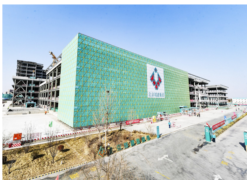
安贞医院通州院区建设项目正在全力推进。记者 常鸣/摄
