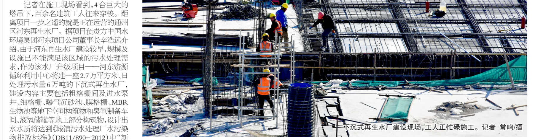
下沉式再生水厂建设现场,工人正忙碌施工。记者 常鸣/摄
