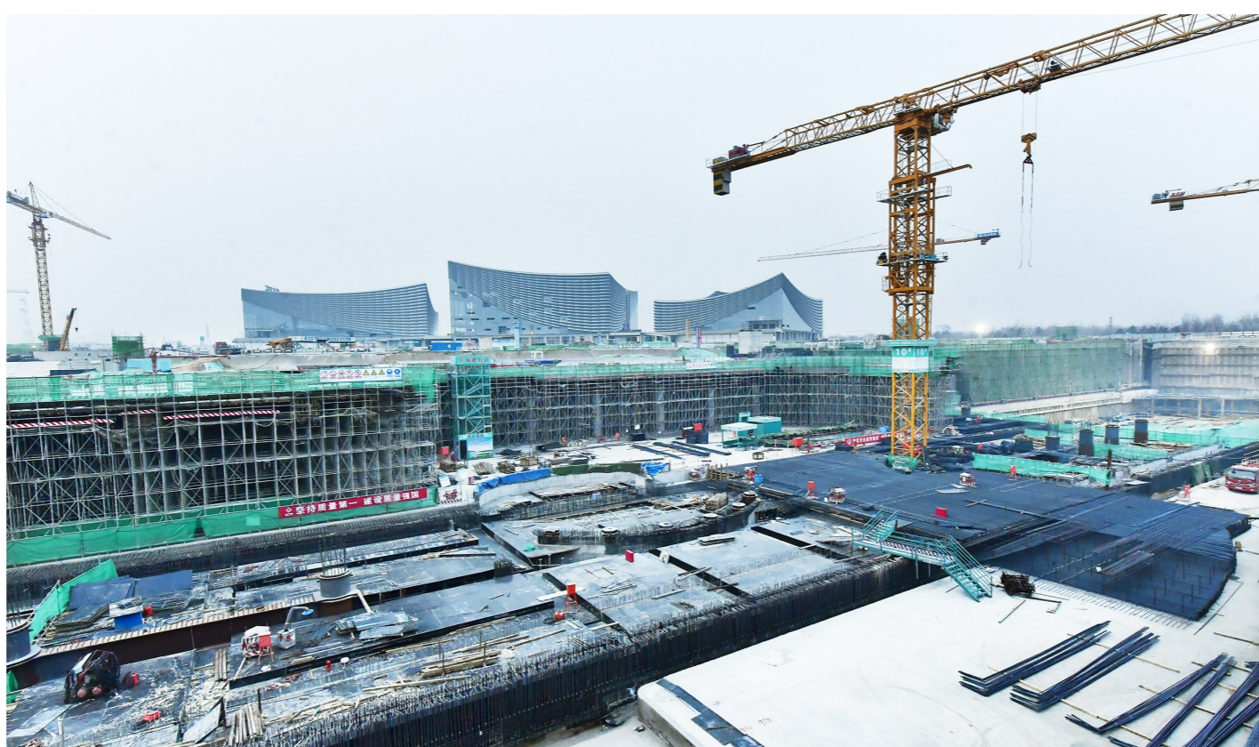
轨道交通M101线“北京大剧院站”正在紧张施工。记者 唐建摄
