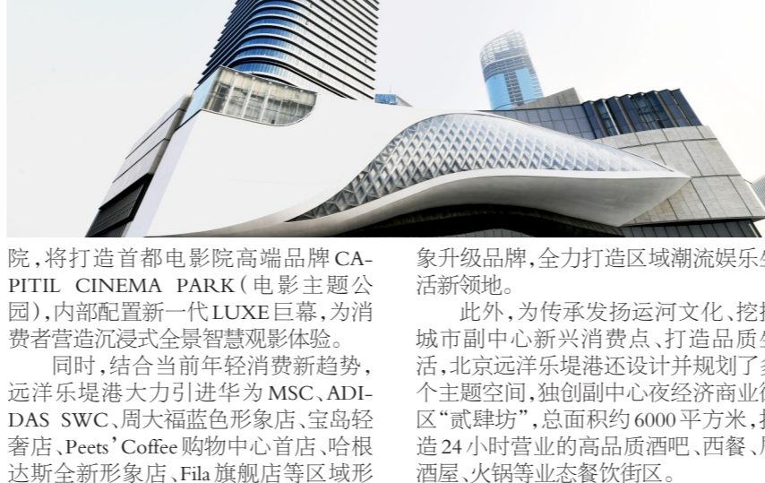
远洋乐堤港项目位于运河商务区先行启动区,包含一座10万平方米购物中心和两座5A级写字楼。记者 常鸣/摄
