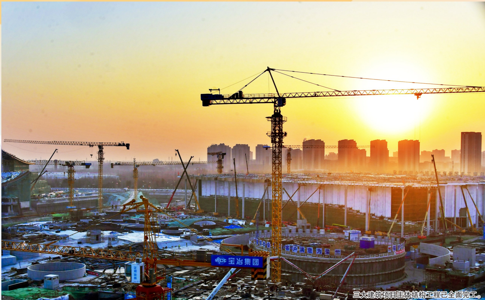
三大建筑项目主体结构工程已全面完工。
