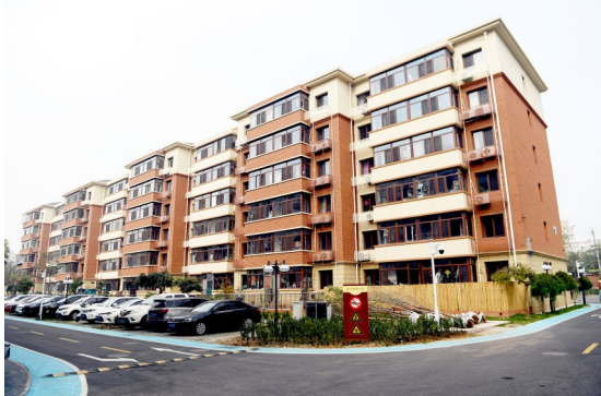
老旧小区改造后,居民住得更舒心。记者 党维婷/摄
