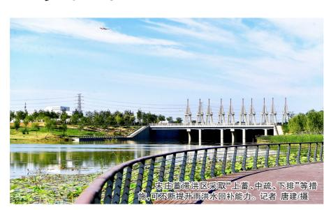
成部分,当洪峰来临时,可通过尹各庄分洪 闸、尹各庄拦河闸联合调度,把从温榆河 上游下泄的洪水分洪到宋庄蓄滞洪区,从 而减少北运河下游的行洪压力,将在降雨 中蓄滞雨水470万立方米,为城市副中心保
