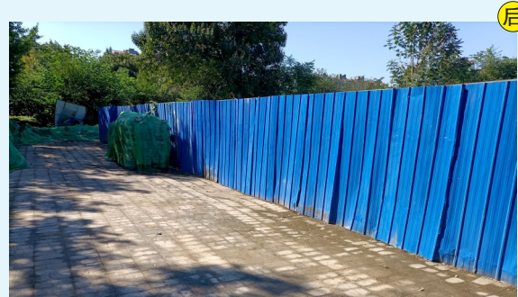
梨园镇日新路北京现代音乐研修学院西北268米-乱倒乱卸垃圾
