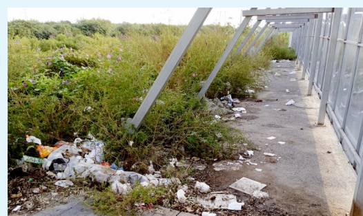
宋庄镇潞苑北大街与滨榆东路交叉口北侧-积存垃圾
