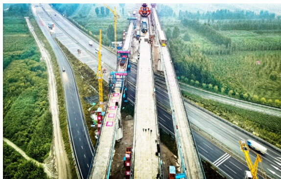
新建首都国际机场至北京大兴国际机场城际铁路联络线一期工程跨密涿高速连续梁全部实现主跨合龙。曹建强/摄
