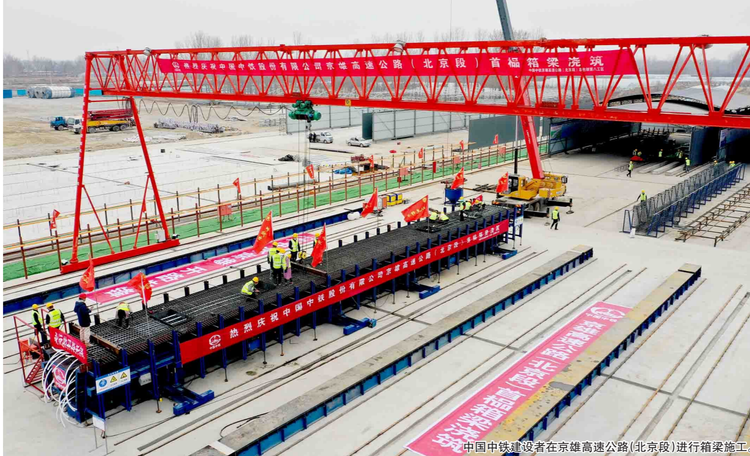
中国中铁建设者在京雄高速公路(北京段)进行箱梁施工。
