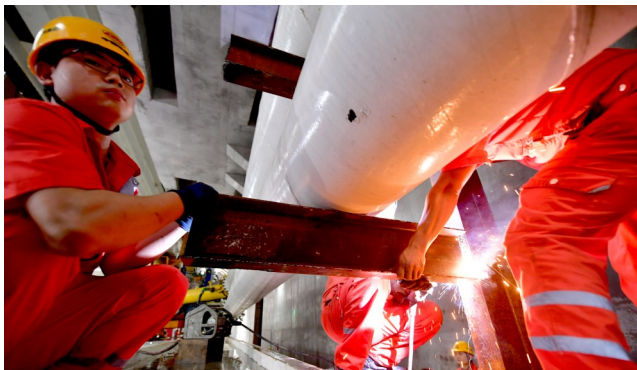
盾构机每掘进10米就要延伸一次泥浆管。
